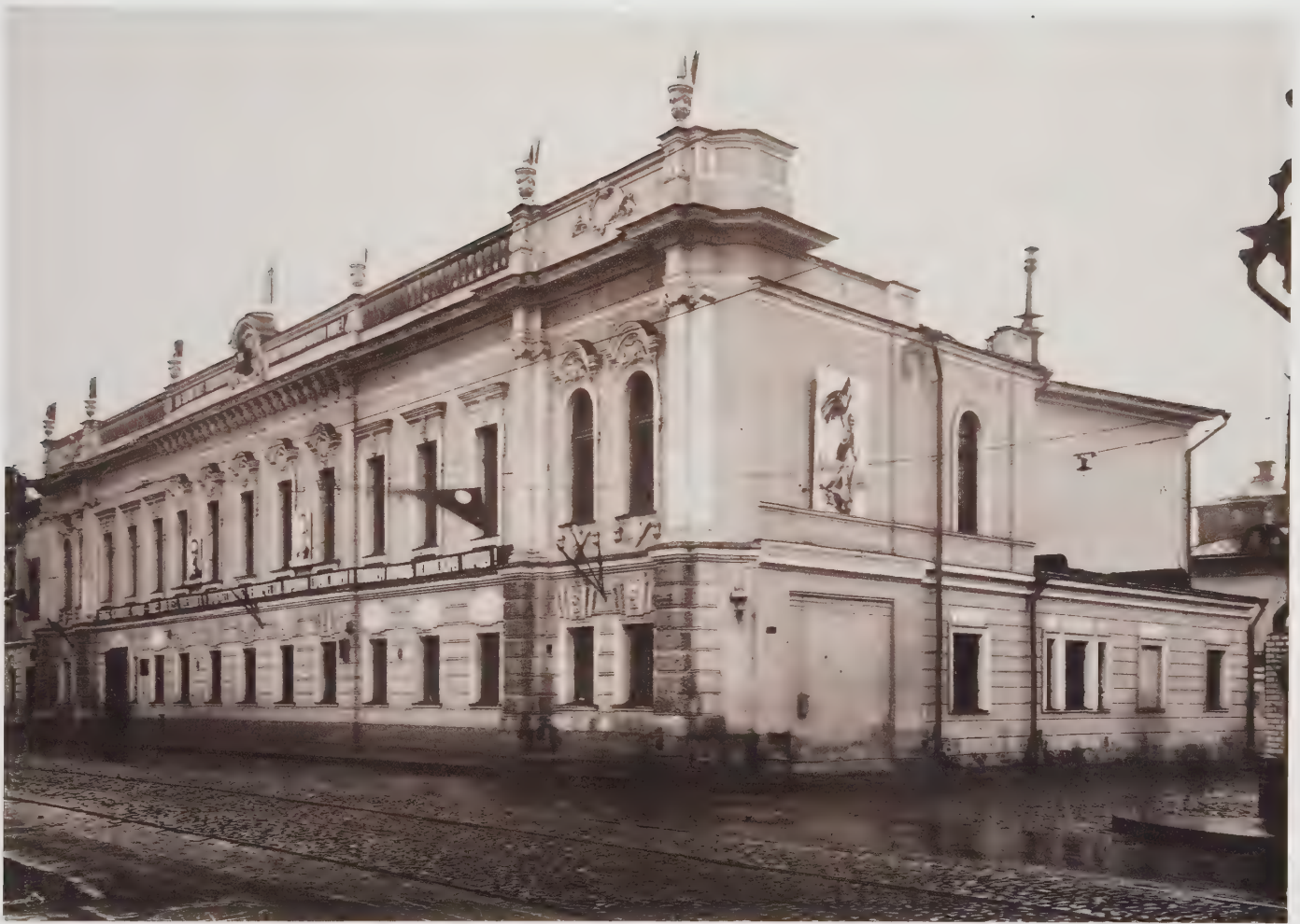
Bâtiment du Musée d'art moderne occidental (ancienne demeure d'Ivan Morozov). Env. 1937.
